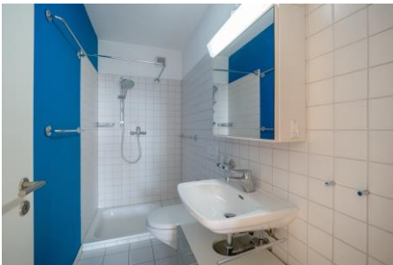
Dusche/WC im Mittelgeschoss
