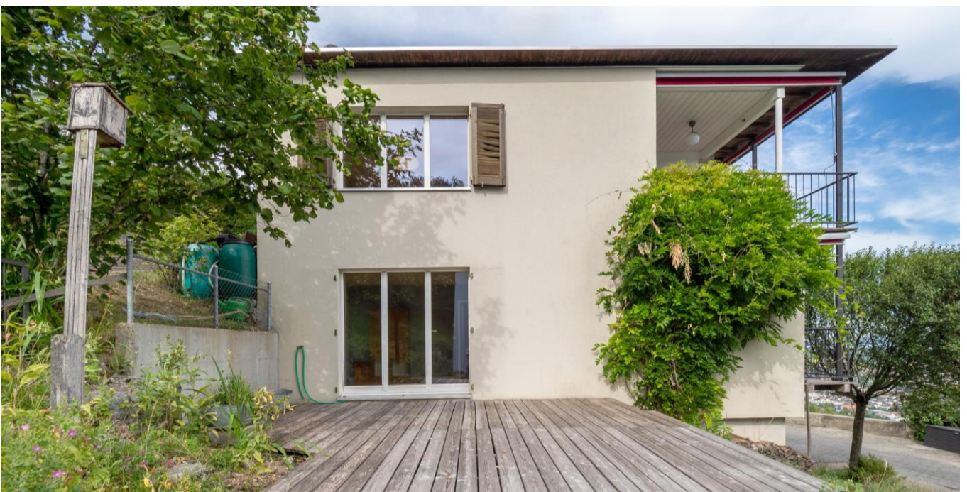
Mittelgeschoss - Terrasse West – zugänglich von Zimmer 1
